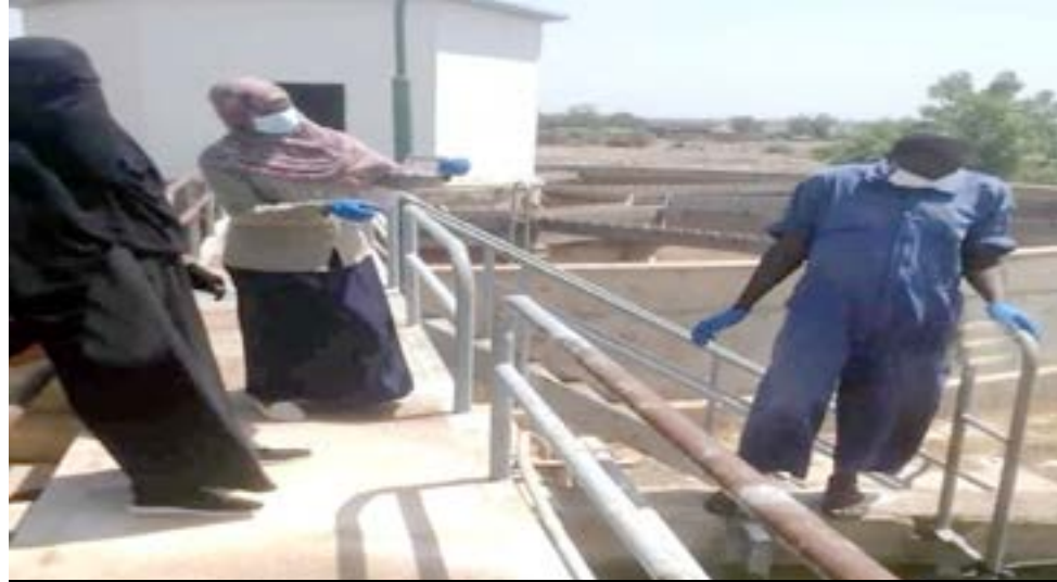
المهندسة منيرة - شمال الصورة - أثناء عملية فحص الكلور
